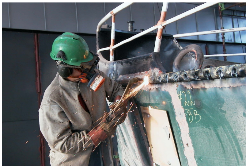
Utbrenning av nagler i fenderlist (foto: BDF)
