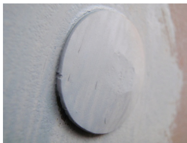
Naglens slutthode er korrekt påført sinkprimer for å unngå korrosjon etter klinking
