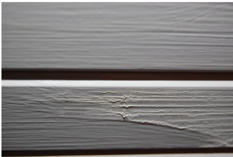
Her er linoljemaling påført i for tykke strøk med det resultat at malingen rynker seg.
