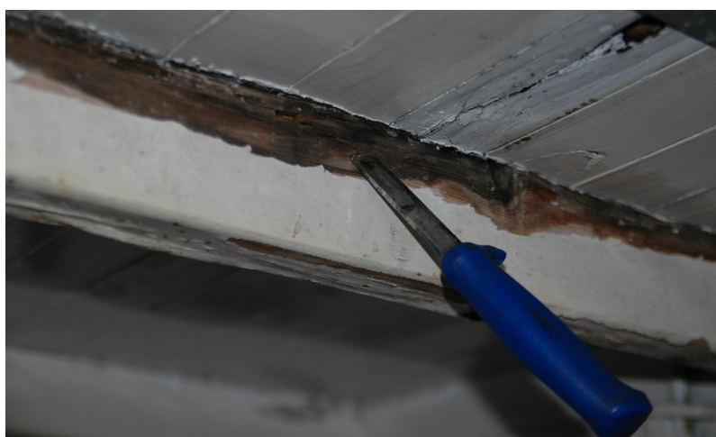
Kniven går flere centimeter inn. Det er begynnende råte.
