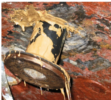
Her er gjennomføringa isolert med krympestrømpe og gummipakning. Boltene isoleres også fra godset.
